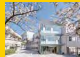
E 8号館(2023年4月完成)
